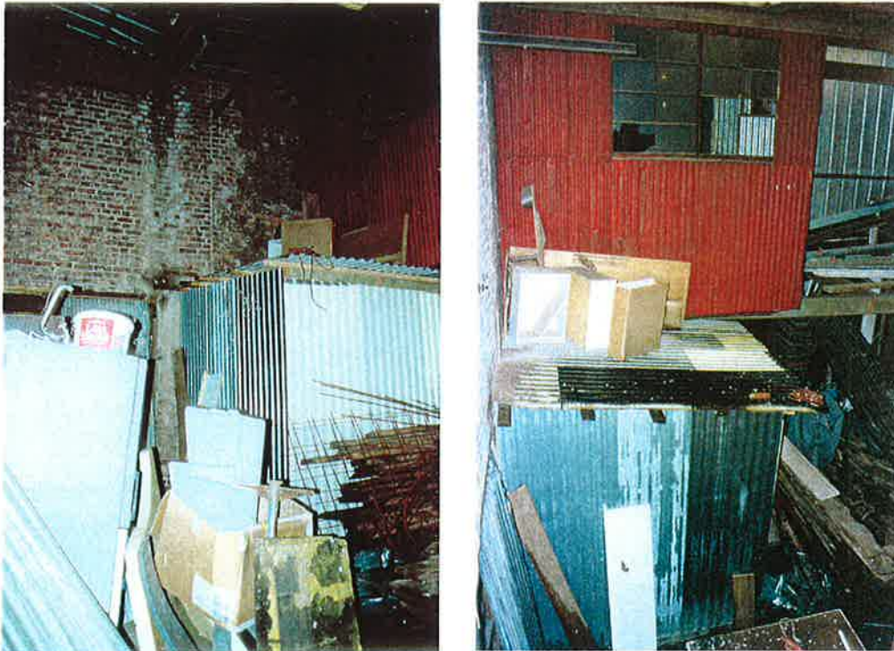
Gården på Tredjelånggatan 26. Den tegelvägg vi ser till vänster är rester av smidesverkstadens fasad. 2004.
